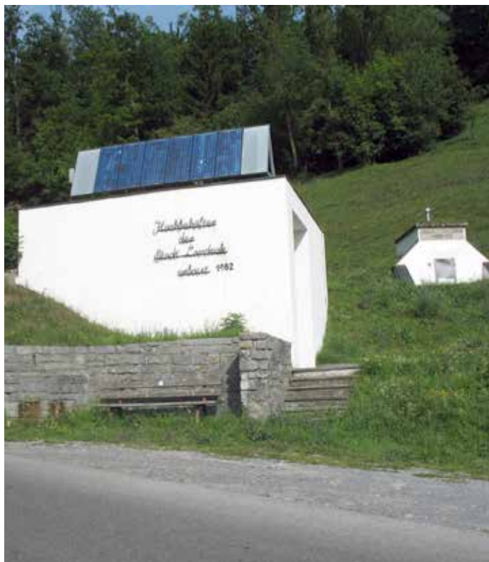
Der Hochbehälter in Grins.
