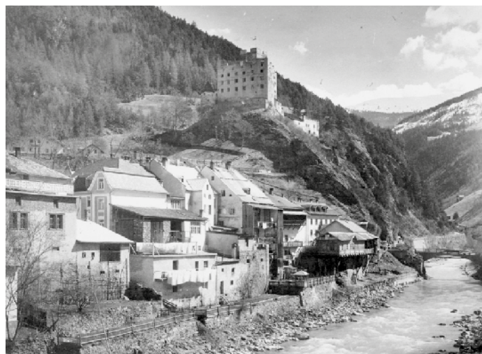
Blick zur Gerberbrücke kurz vor dem Bau der Reschenbahn im Jahre 1917.
